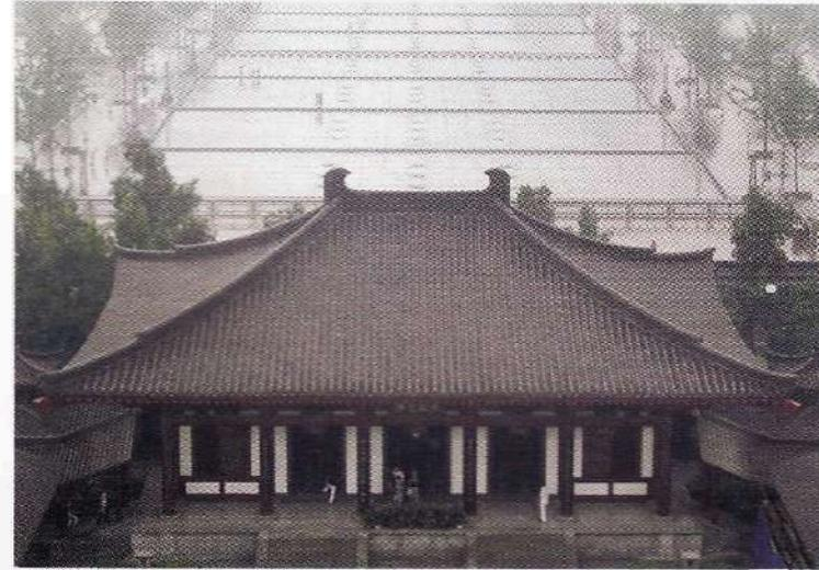
**Cubierta de pabellón compuesto.** Estructura a cuatro aguas con dos vertientes menores. Que incluyen un corte perpendicular
