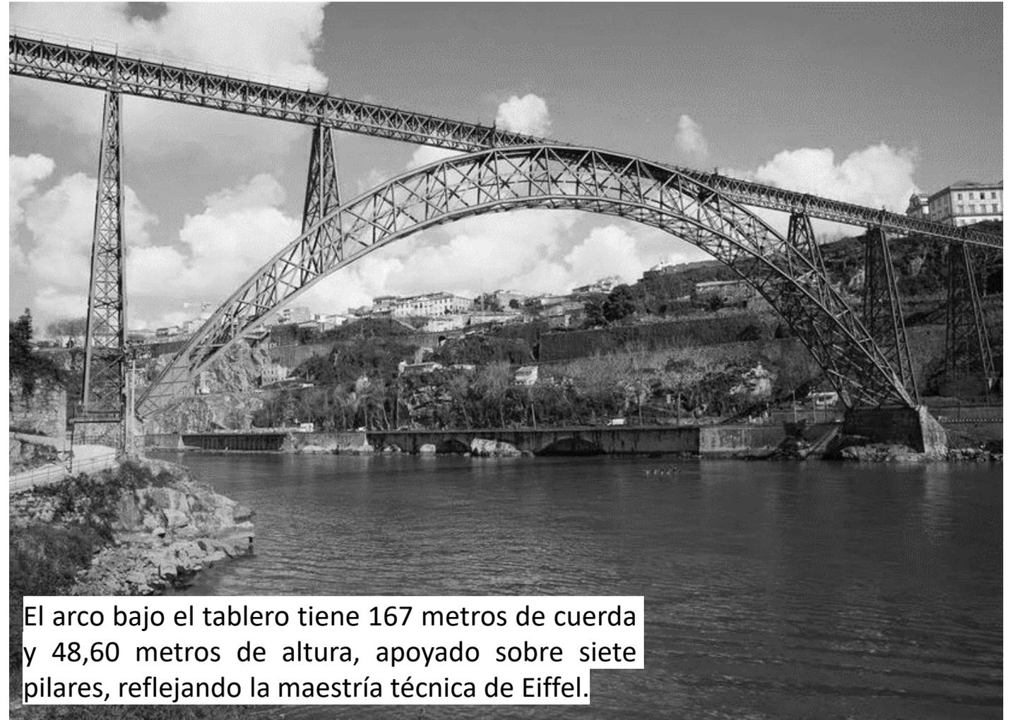
El arco bajo el tablero tiene 167 metros de cuerda y 48,60 metros de altura, apoyado sobre siete pilares, reflejando la maestría técnica de Eiffel.
