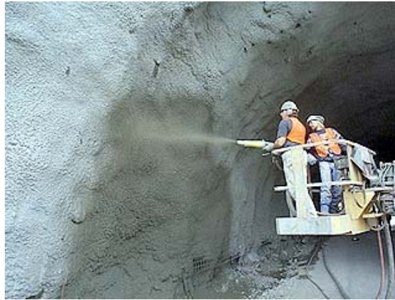
Figura 1.24: Hormigón lanzado o proyectado (shotcrete).
