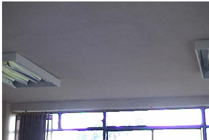
Figura 9.31: Viga descolgada extrema que representa apoyo.
