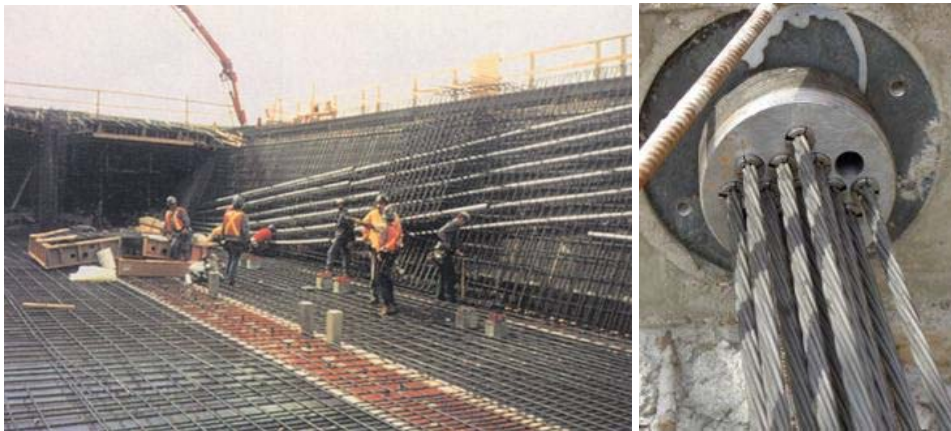
Figura 3.4: Tendido de ductos para cables de acero de preesfuerzo y sistemas de anclaje de cables.
