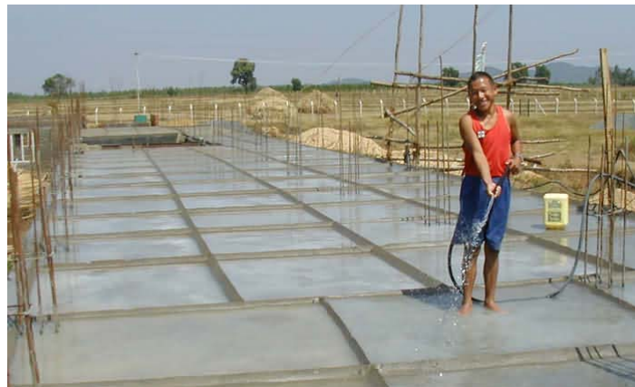
Figura 1.17: Curado del hormigón.
