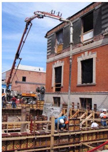
Figura 1.22: Hormigón bombeado.
