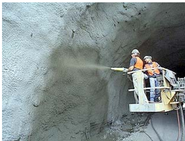
Figura 2.12: Hormigón lanzado de fraguado rápido.
