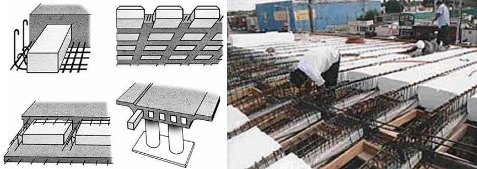
Figura 9.12: Poliestireno expandido en la construcción de losas alivianadas.
