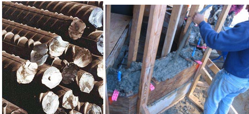
Figura 4.2: Acero corrugado y hormigón vibrado.
