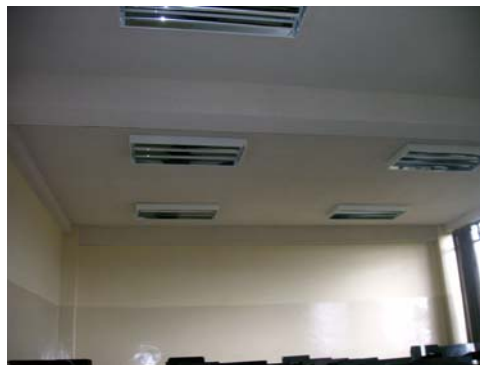
Figura 9.18: Losa bidireccional apoyada sobre cuatro vigas descolgadas.
