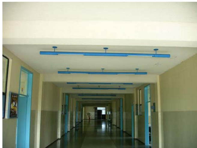
Figura 9.2: Losas sobre vigas descolgadas.
