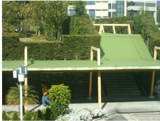
Figura 9.1: Losas de hormigón armado sobre pórticos metálicos.
