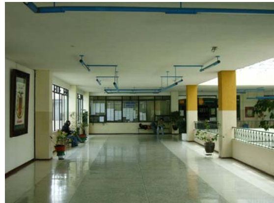
Figura 9.5: Losas con vigas embebidas.
