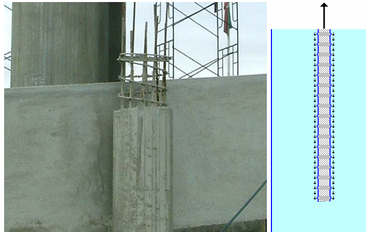
Figura 4.1: Integración del hormigón y el acero de refuerzo.
