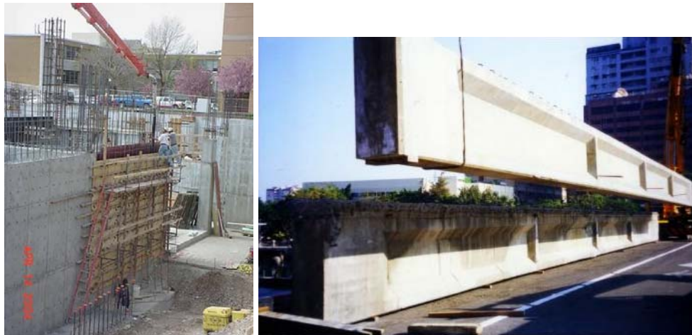
Figura 1.4: Hormigón armado y hormigón preesforzado.
