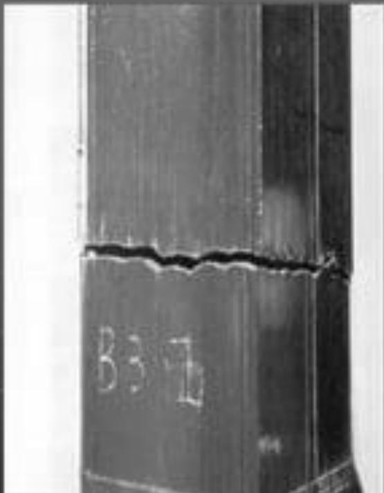
Kobe, 1995. Fractura de una columna de acero (tubular cuadrado)
