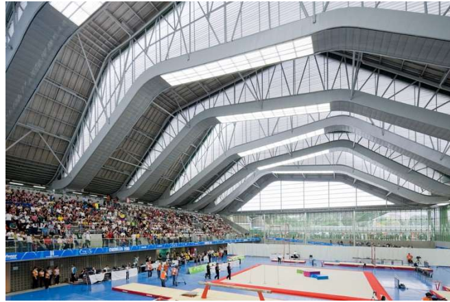
Construcción de un Coliseo de Deportes
