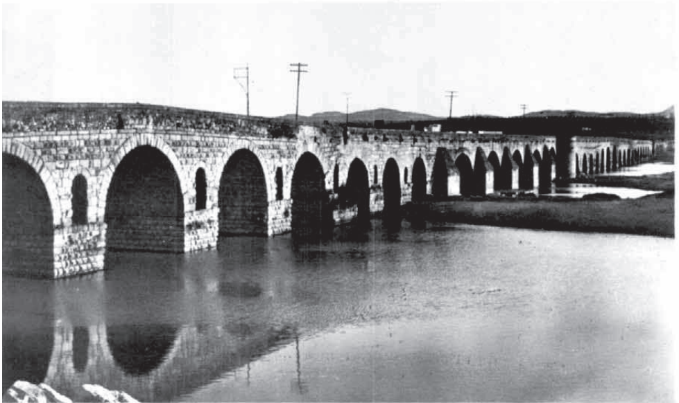
24 - Mérida, el puente romano sobre el río Guadiana.
