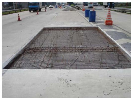
**Figura 1.47:** Pavimento rígido de hormigón resistente a la abrasión.
