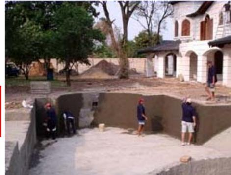
**Figura 1.46:** Hormigón impermeable.
