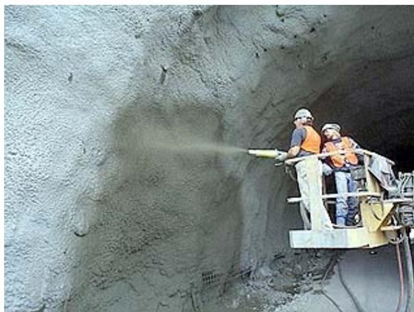
**Figura 2.12:** Hormigón lanzado de fraguado rápido.
