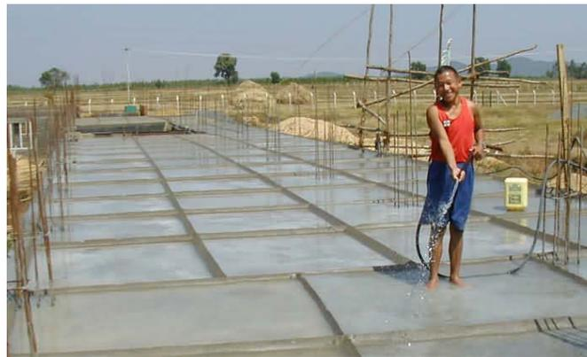
*Figura 1.17: Curado del hormigón.*
