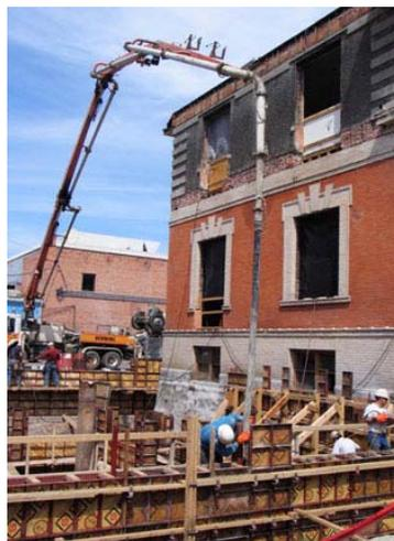
*Figura 1.22: Hormigón bombeado.*
