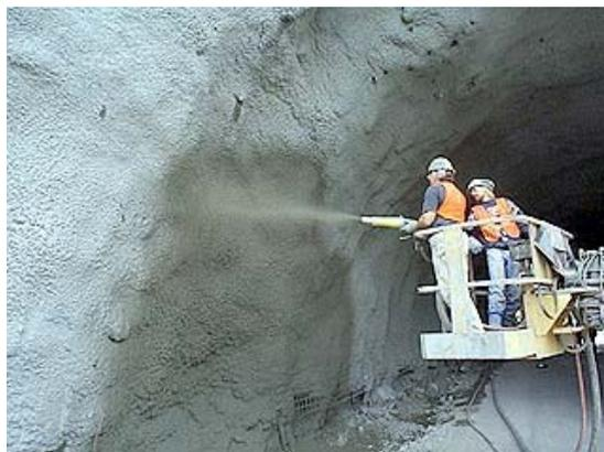
**Figura 1.24:** Hormigón lanzado o proyectado (shotcrete).
