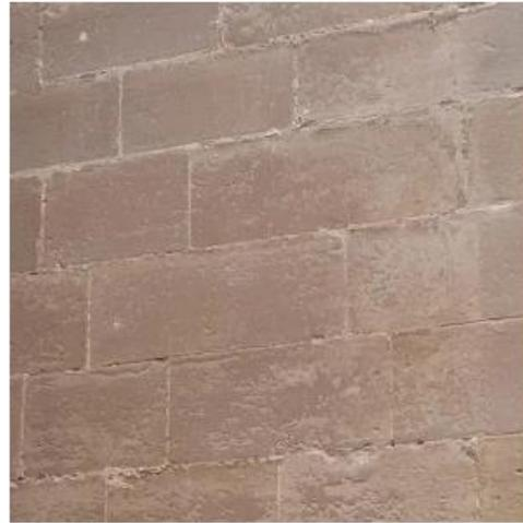
La sillería es un aparejo a base de sillares, es decir, piedras labradas en todas sus caras en forma de paralelepípedo, que forman parte de una fábrica de piedra o muro de aspecto regular. Los sillares pueden estar colocados a hueso, o recibidos con mortero.
