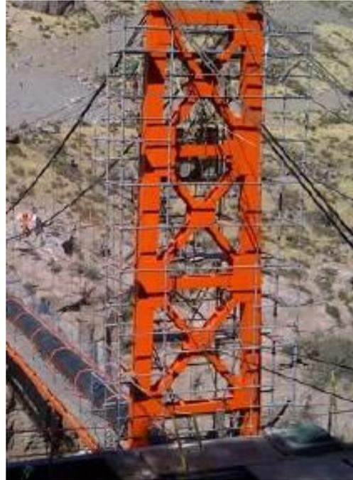
Sostienen a los cables principales y secundarios, que a su vez estos sostienen al tablero, También se caracterizan por la forma de los pilares (forma de H, de Y invertida, de A, de A cerrada por la parte inferior (diamante)).
