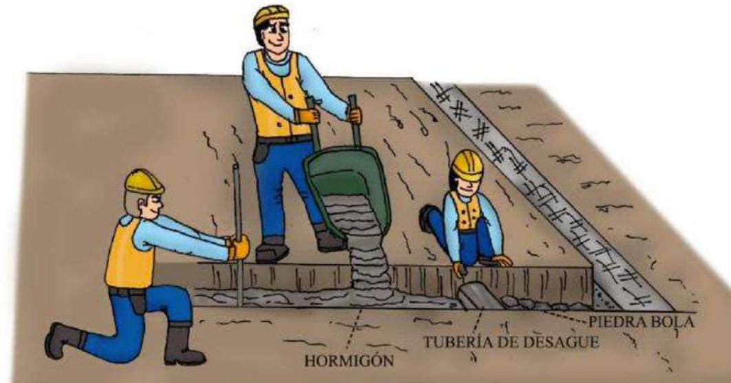
Figura 44: **Fundición del cimiento de la cadena.**
