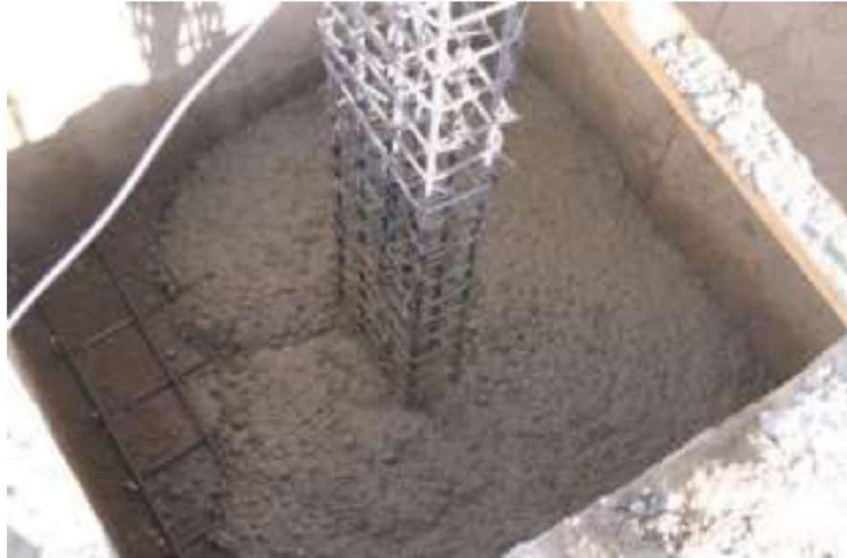
Figura 42: **Fundición de plintos.**
