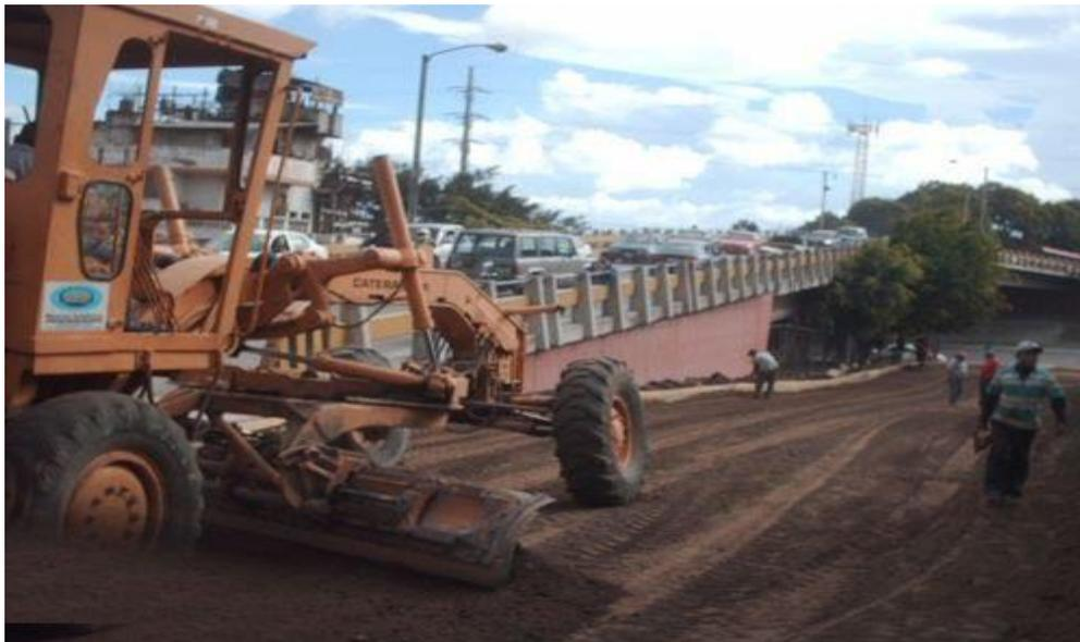
**Gráfico – Relleno compactado mecánicamente con sub-base (tendido 02)**
