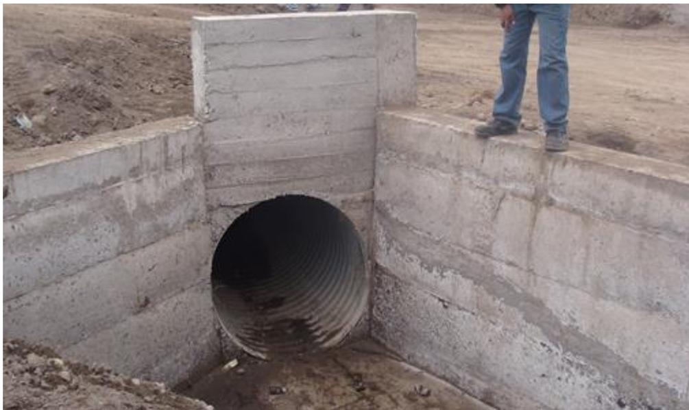
**Gráfico – Cabezales de entrada y la salida de las alcantarillas**
