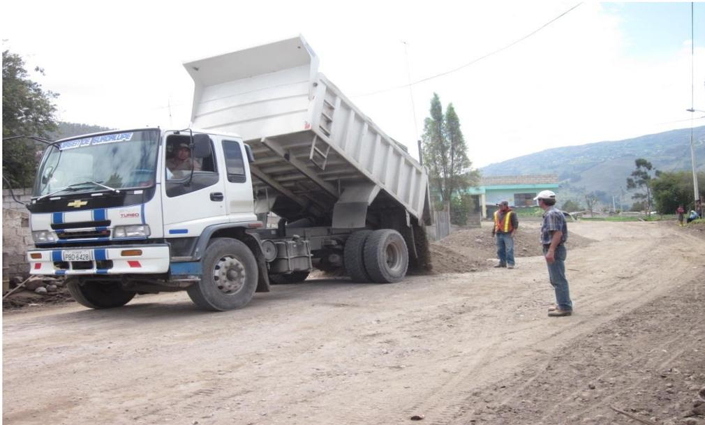
**Gráfico – Relleno compactado mecánicamente con sub-base (colocación 01)**
