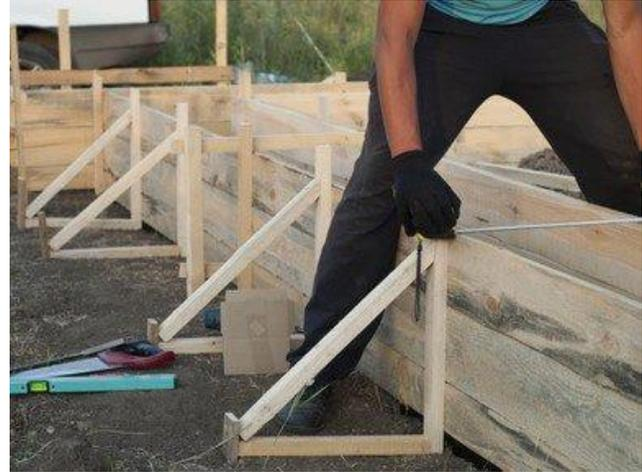
**Gráfico – Encofrado de madera de sección rectangular de canal**
