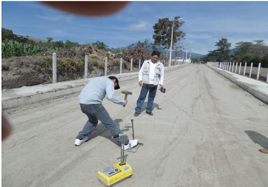
**Gráfico – Relleno compactado mecánicamente con sub-base (pruebas 04)**
