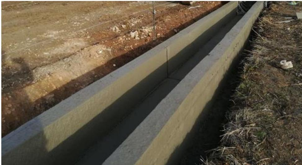
**Gráfico – Sección de canal revestida con hormigón simple**
