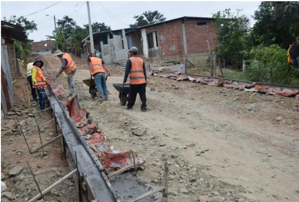
**Gráfico – Bordillos hormigón simple (vertido de hormigón simple en ingreso vehicular 02)**
