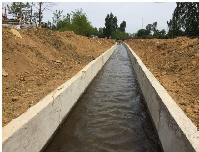
**Gráfico –Sistema de riego a gravedad mediante canal revestido**
