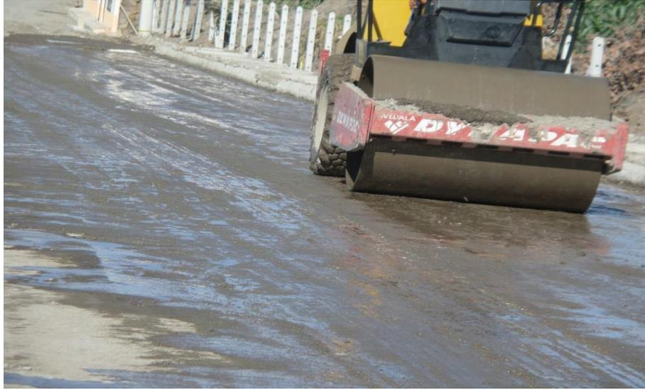
**Gráfico – Relleno compactado mecánicamente con sub-base (compactación 03)**
