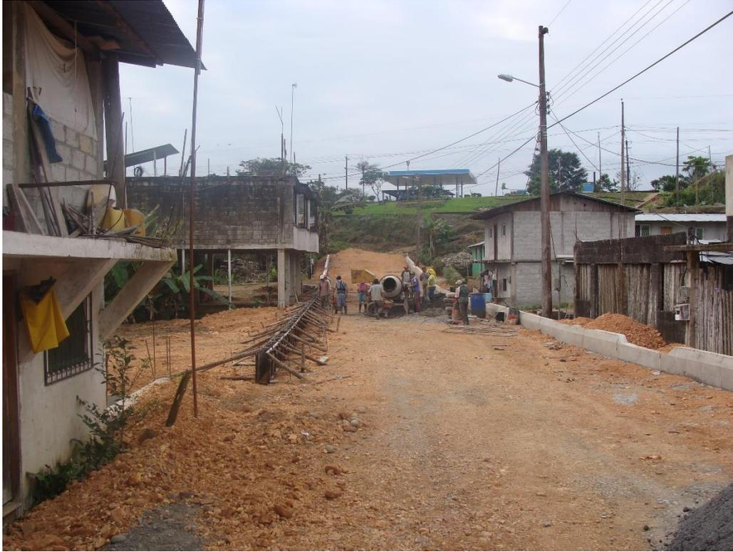
**Gráfico – Bordillos hormigón simple (colocación de formaletas y vertido de hormigón simple 01)**
