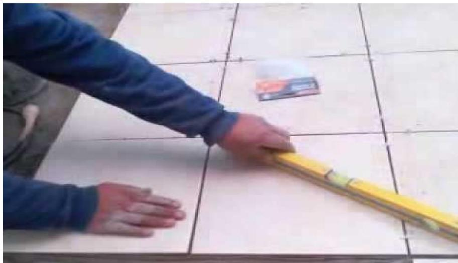
**Gráfico – Comprobando nivelación de cerámica sobre mortero en piso**
