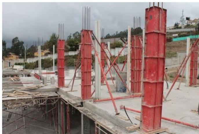
**Gráfico – Detalle de encofrado de tercer tramo de columna**
