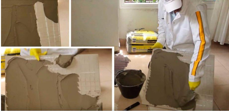
**Gráfico – Detalle de la colocación del mortero en cerámica**
