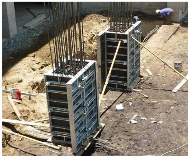
Gráfico – Encofrado de columna con tablero metálico
