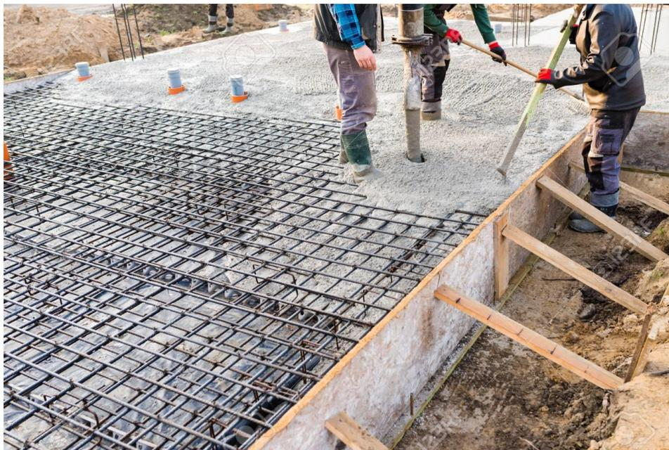
**Gráfico – Vertido de hormigón en losa**
