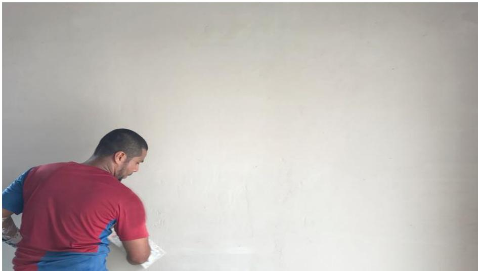
**Gráfico – Detalle de paso 04, lijado y limpieza final de empaste**
