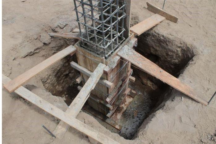
Gráfico – Encofrado en primer tramo de columna
