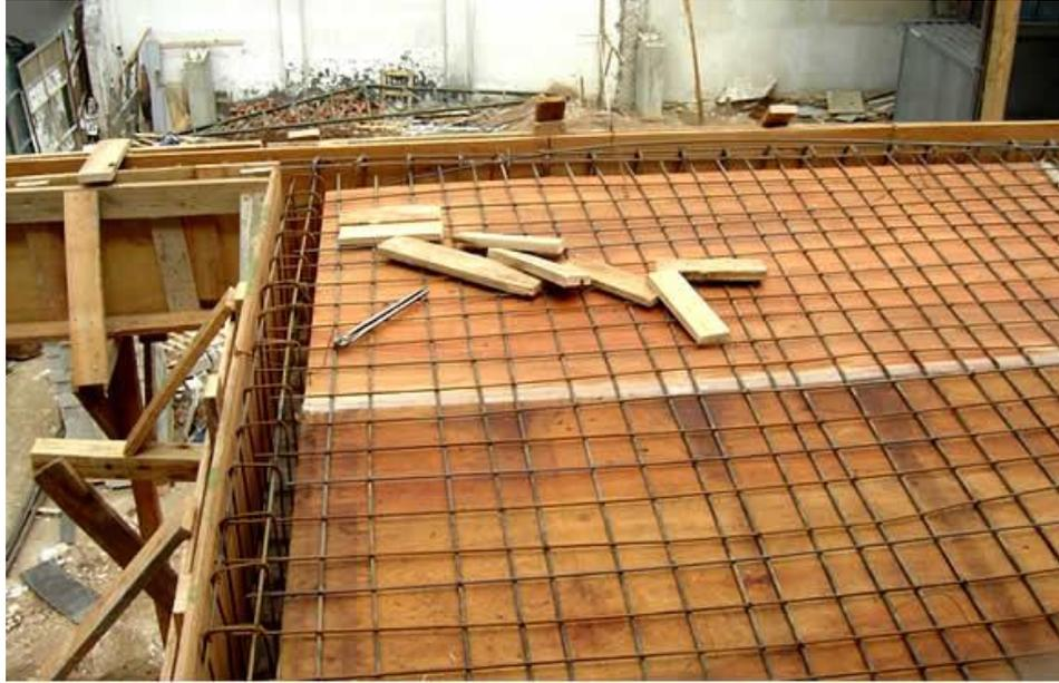
**Gráfico – Encofrado de madera para losa junto al encofrado de una viga**
