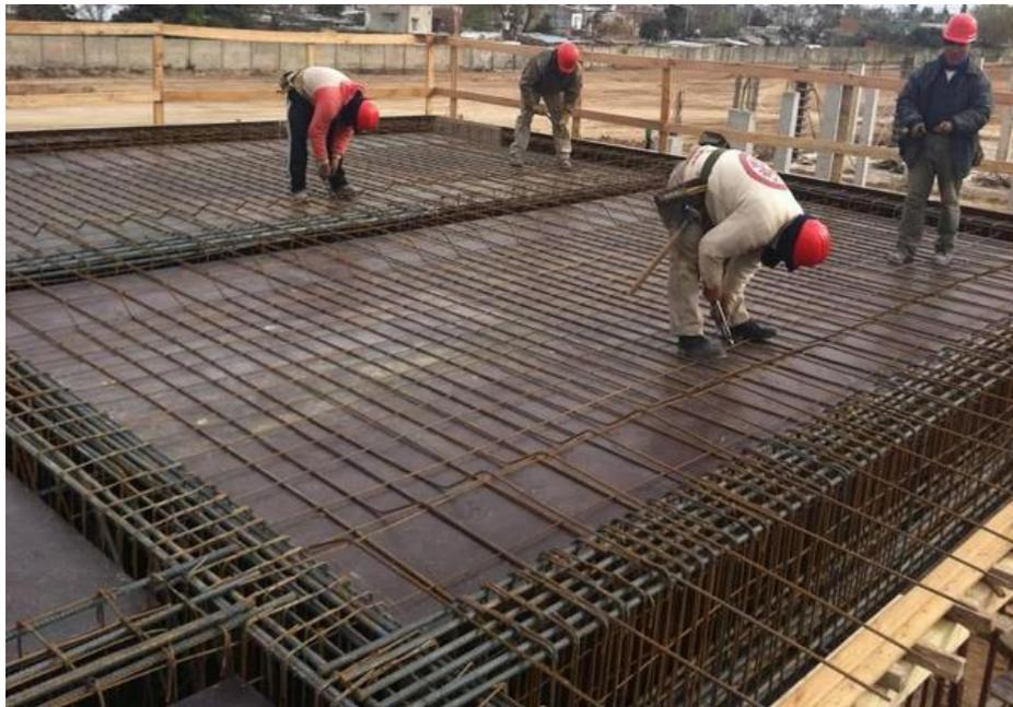
**Gráfico – Colocación y ubicación de acero de refuerzo en losa**
