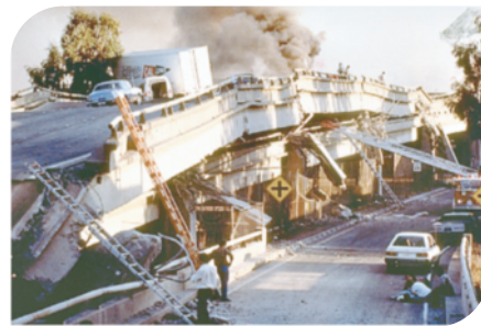
FIGURA 14.25 a) Oscilación de gran amplitud del puente Tacoma Narrows, debido a ráfagas de viento, que condujeron a su colapso (1940). b) Derrumbe de una autopista en California, causado por el sismo de 1989.
