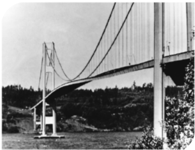
FIGURA 14.25 a) Oscilación de gran amplitud del puente Tacoma Narrows, debido a ráfagas de viento, que condujeron a su colapso (1940). b) Derrumbe de una autopista en California, causado por el sismo de 1989.
