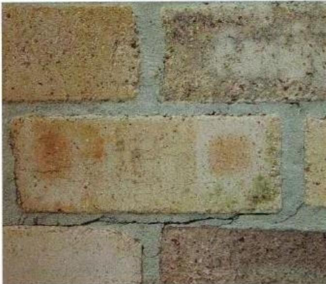
Foto 41: Nótese las fisuras en la pega entre el ladrillo y el mortero.
