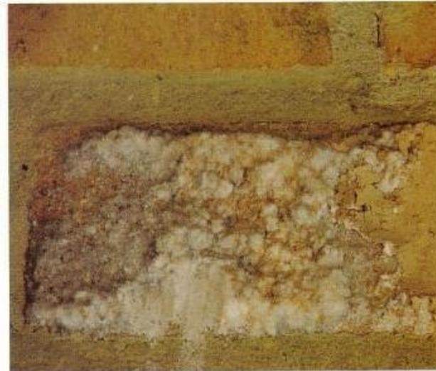
Foto 49. Cristalización producida por el ataque de sales que ha ocasionado la destrucción de la pieza de arcilla.
