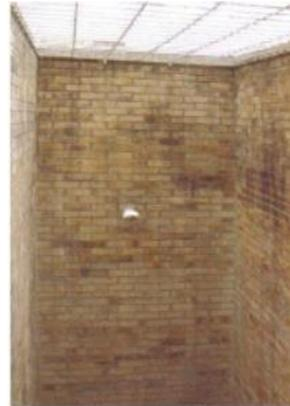
Foto 43: Nótese la aparición de eflorescencias por arrastre de suciedad y acción de la lluvia en una fachada sin ninguna protección.
