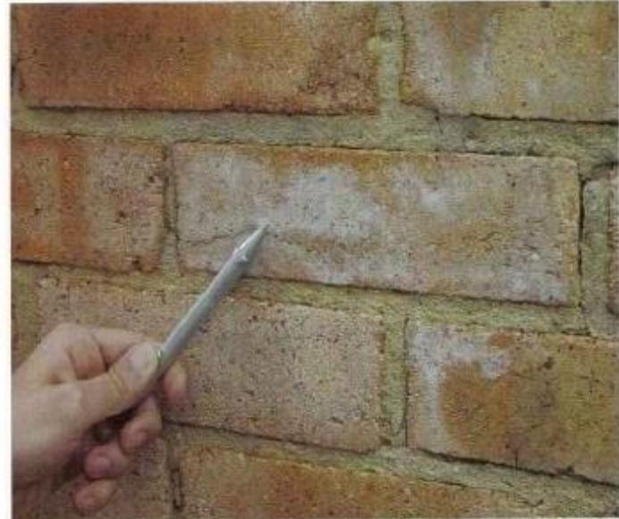
Foto 42: Fisuración del material por causas mecánicas.
