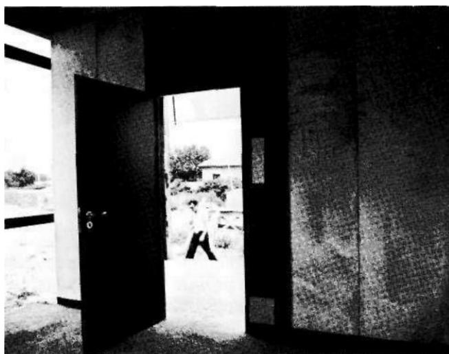
Colocación de la puerta prefabricada en el modelo. En la pared próxima a la puerta se observa un boceto de una posible variante de la colocación de la puerta
