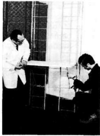
La estructura resulta ligera y casi transparente, abulta poco, en ella apenas se deposita el polvo salvo en la superficie superior de las varillas. Los dos planos horizontales pueden ser desplazados, de abajo arriba, cada veinte centímetros, según se prefiera. Los cuatro montantes sirven como escaleras de acceso al plano superior
