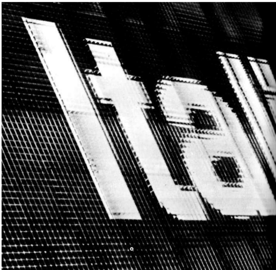
Una parte de la fachada con efectos de luz a través de paneles de rejilla de ABS cromada
