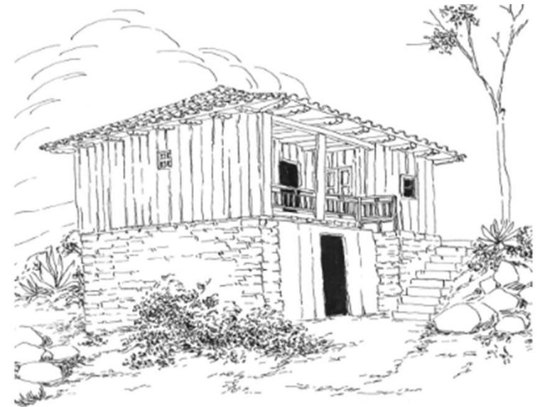
Imagen 28. Edificación en dos plantas con muros mixtos.
