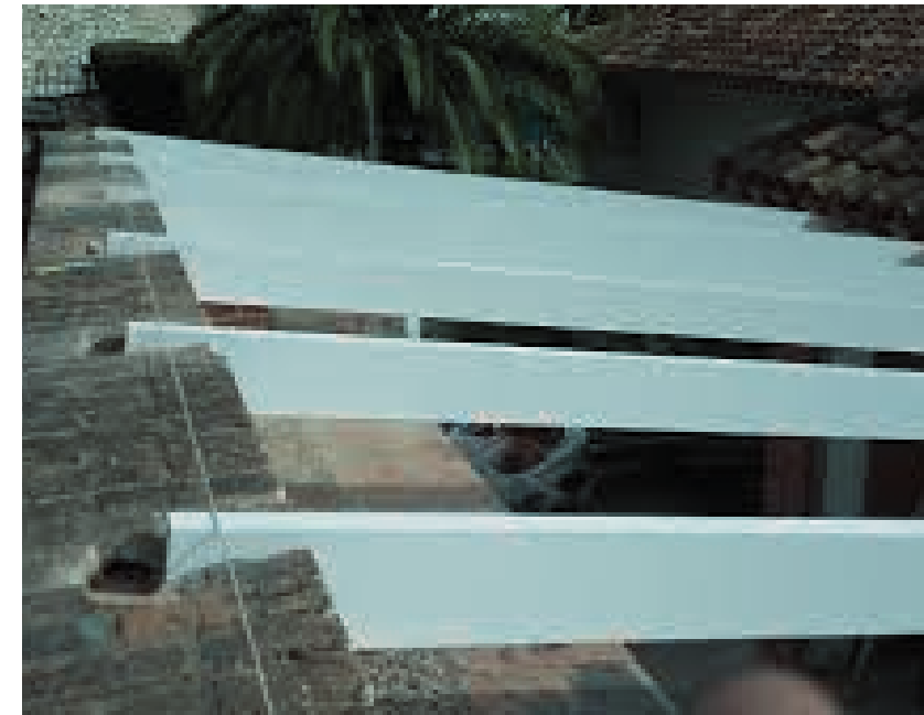
Vigas de Nivelación
