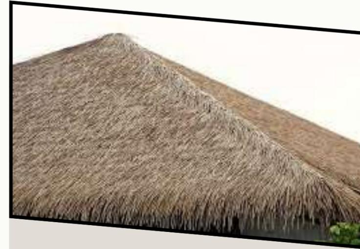
Es un tipo de cubierta de techo tradicional que se construye utilizando fibras naturales como paja, juncos, palmeras u otras fibras vegetales
