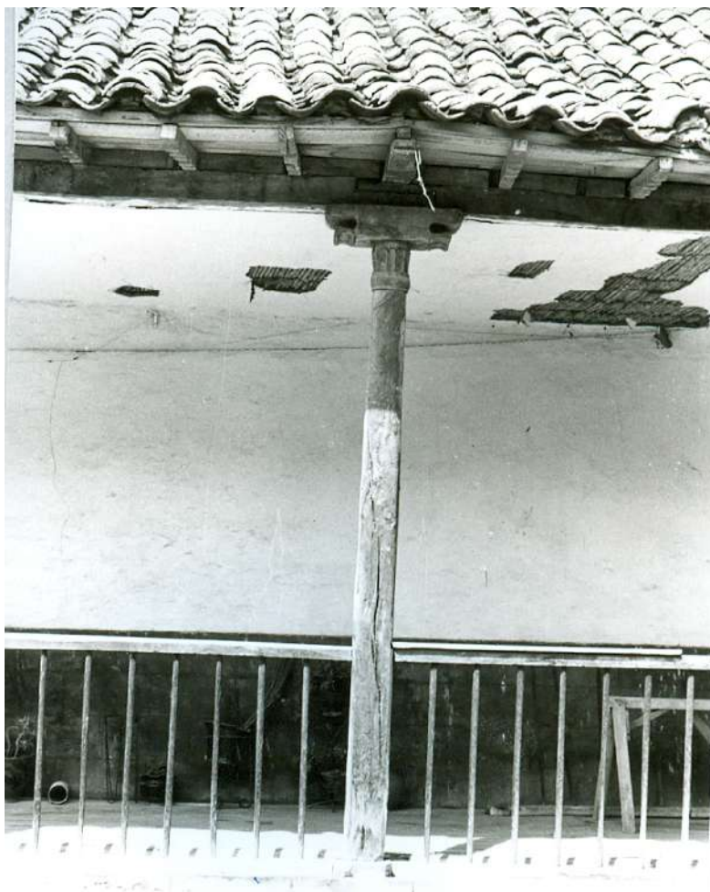
Detalle de pies derechos y barandal.
