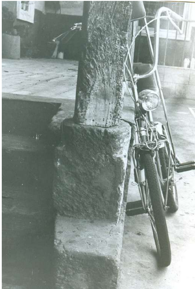
Detalle de podio y base de piedra de los pies derechos.
