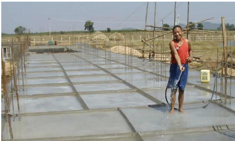
*Figura 1.17: Curado del hormigón.*
