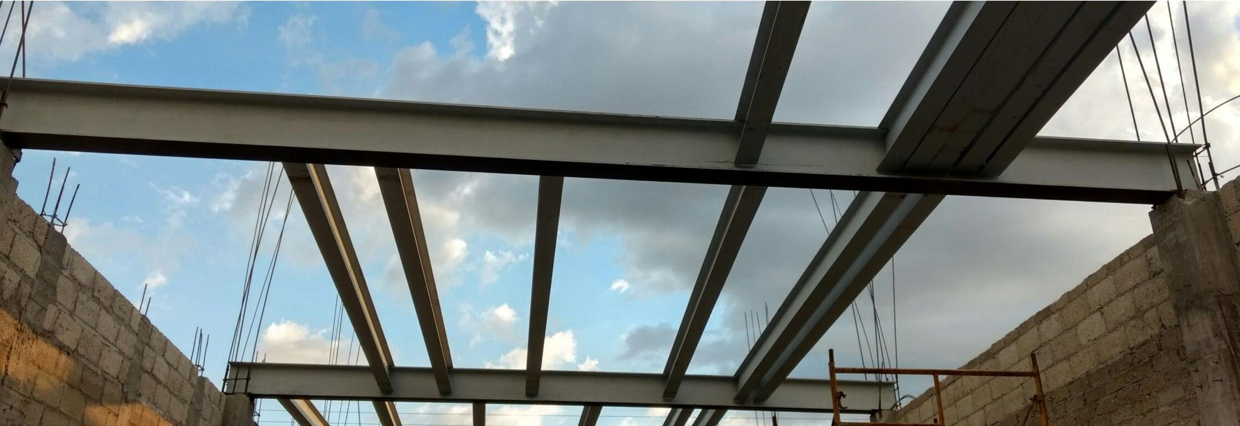
Los perfiles estructurales o vigas como se conocen comúnmente se tratan de tipo de productos fabricados por la técnica de laminación en caliente. El tipo de espesor o la forma que vaya a tener la viga de acero, así como sus cualidades, son los factores que determinarán su aplicación en la ingeniería y la arquitectura. Entre sus características principales destacan la forma, el peso, sus particularidades y la composición química del material con que está hecho.
