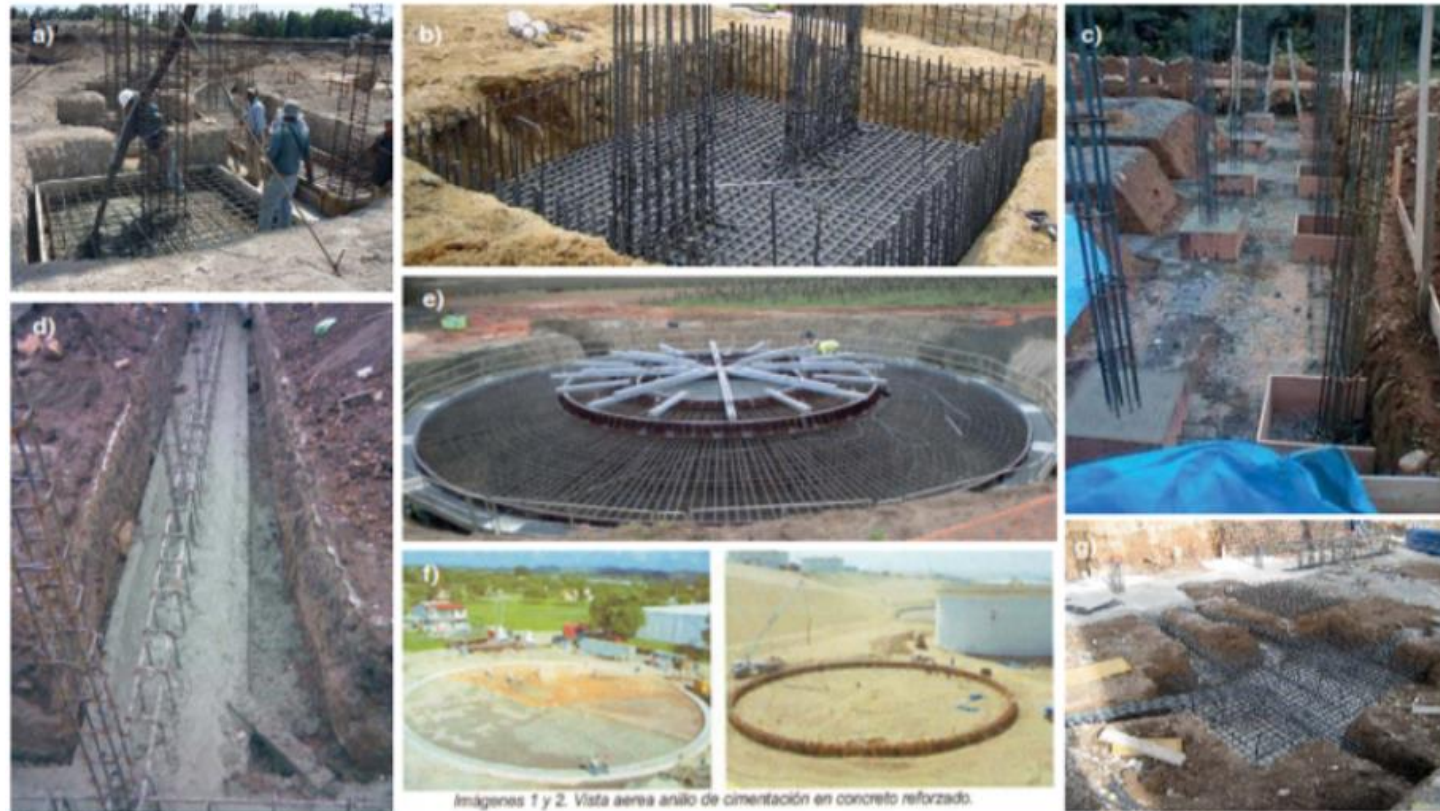
Imágenes 1 y 2. Vista aérea anillo de cimentación en concreto reforzado.
