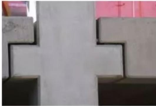
*Nudos que pueden girar y desplazarse horizontalmente. Solo existe la reacción en  $R_y$  vertical*
