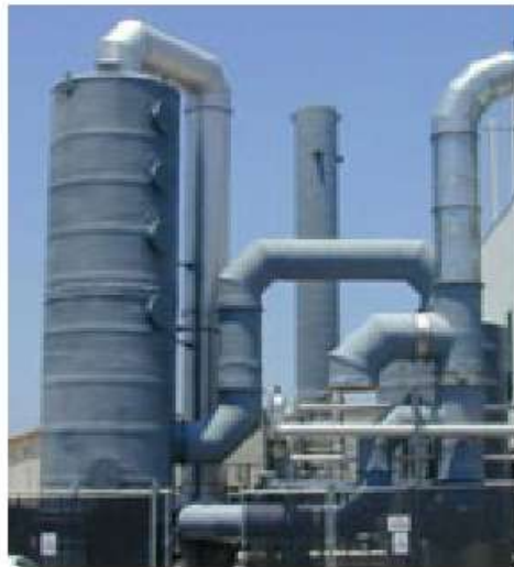
Torre de relleno
