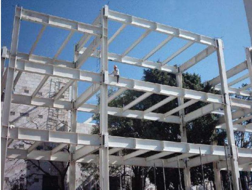
Conjunción de una viga y dos columnas que se unen formando entre sí un nudo rígido capaz de mantenerse indeformable al ser esforzado .
