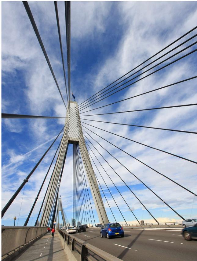
Es un tipo de cable mecánico formado un conjunto de alambres de acero que forman un cuerpo único. Estos alambres pueden estar enrollados de forma helicoidal en una o más capas, generalmente alrededor de un alambre central.
