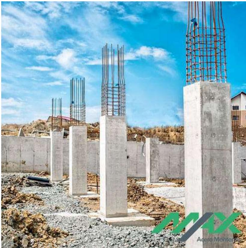
Las columnas son aquellos elementos verticales que soportan fuerzas principalmente de compresión y flexión, encargados de transmitir todas las cargas de la estructura a la cimentación.
