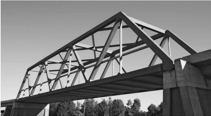
Compuestas por miembros lineales, sujetos a compresión o tensión axial y que se basan en la rigidez del triángulo.
