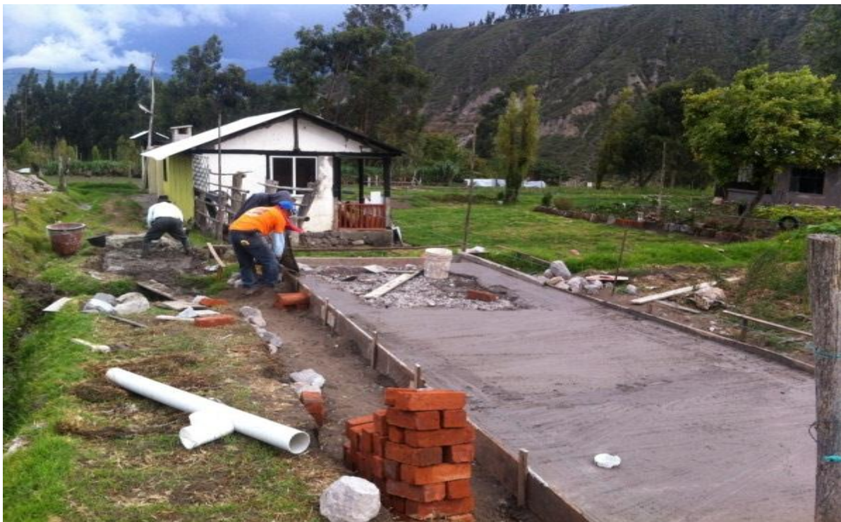
CIMENTACIÓN DE LAS CABINAS DE ENSAYO.
