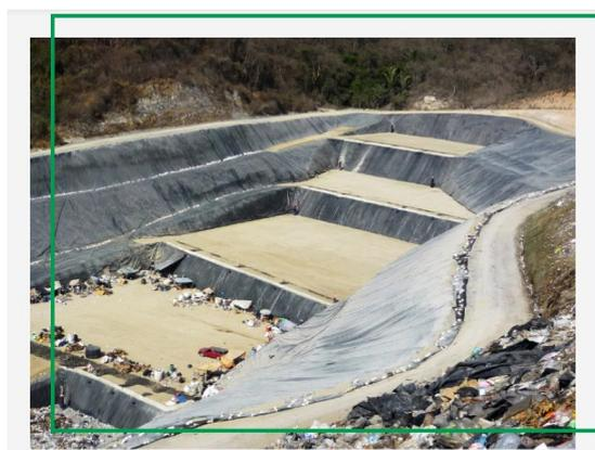
Ilustración 102. Geomembrana en Relleno Sanitario
