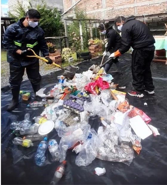
**Fotografía 5.** Homogenización de los RSU.
