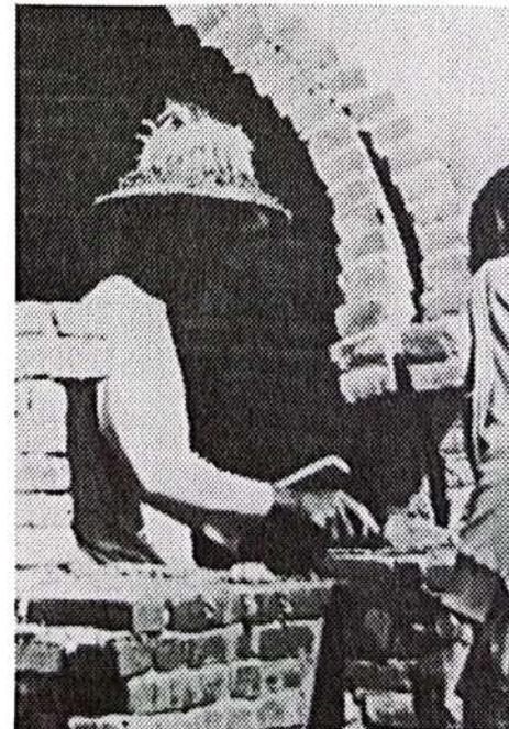
*Construcciones de muro macizo y con cavidad en dos proyectos de ADAUA en Mauritania (Fotos: D. Deriaz)*
